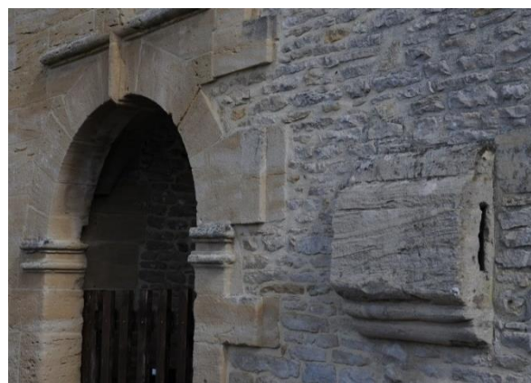
Détail de la meurtrière à ouverture bilatérale
